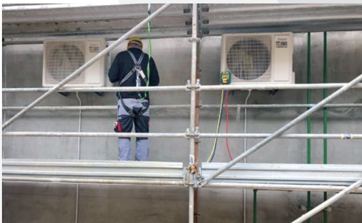
2N, ugradnja Vaillant klima uređaja u INA-i
