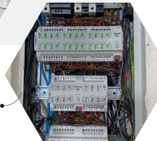
Kako izgleda ožičenje KNX sustava
