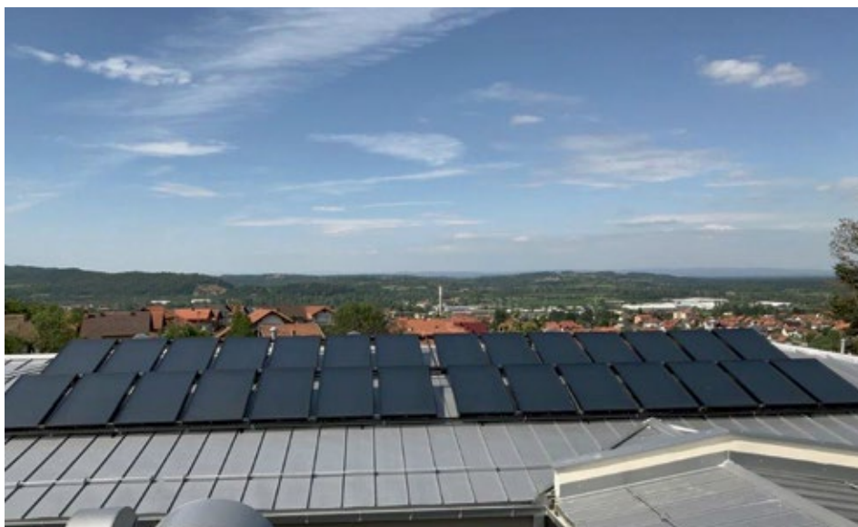
Studentski dom - ugradnja 50 solarnih kolektora
