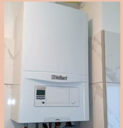
Ugrađeni plinski uređaj VUW 116/5-3
