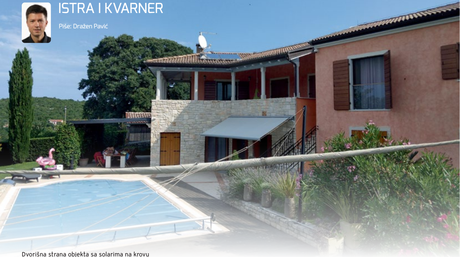
Dvorišna strana objekta sa solarima na krovu
