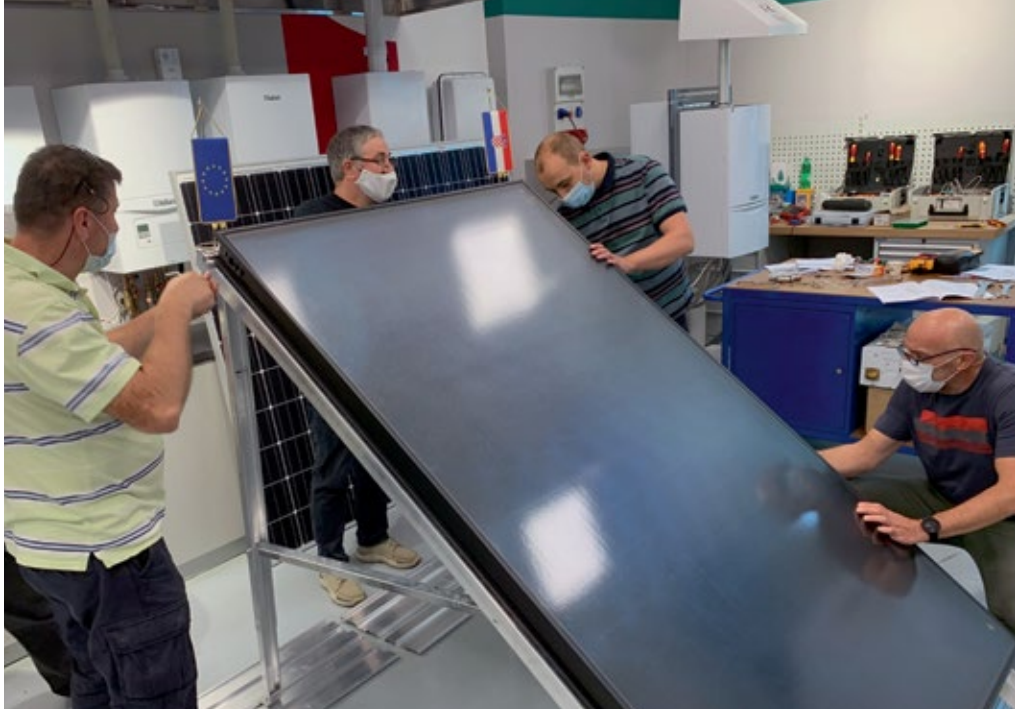
Praktični dio edukacije - montažni pribor za postavljanje kolektora na ravni krov
