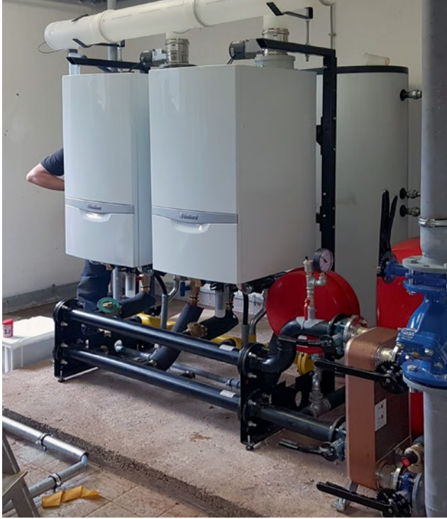
HEP ODS u Orahovici - 2x ecoTEC plus VU 1206/5-5
