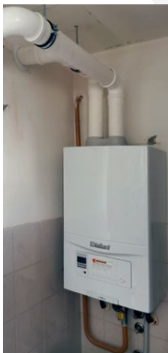
Postavljanje kondenzacijskog bojlera ecoTEC pro
