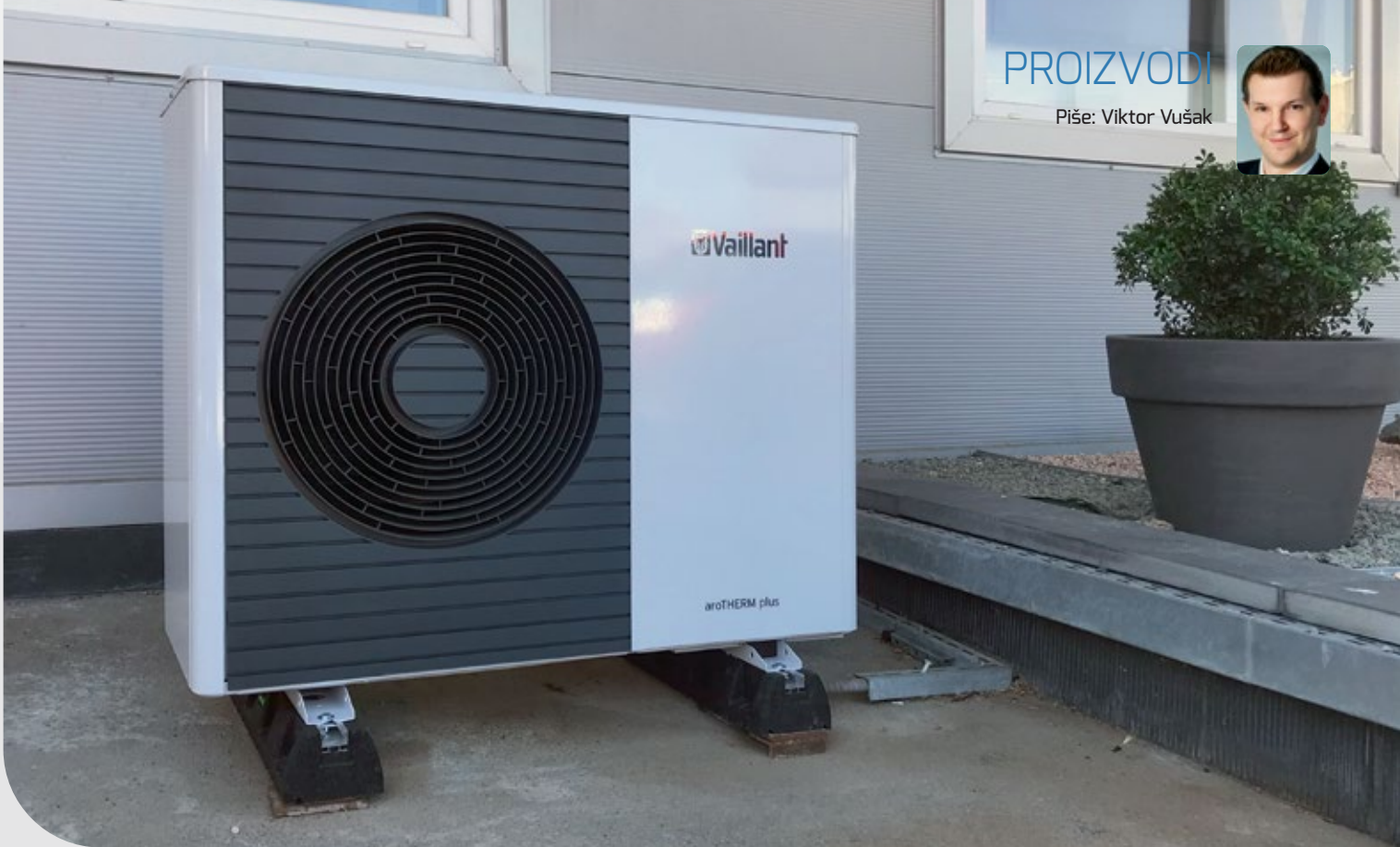
Vanjska jedinica aroTHERM plus na originalnim gumiranim montažnim šinama
