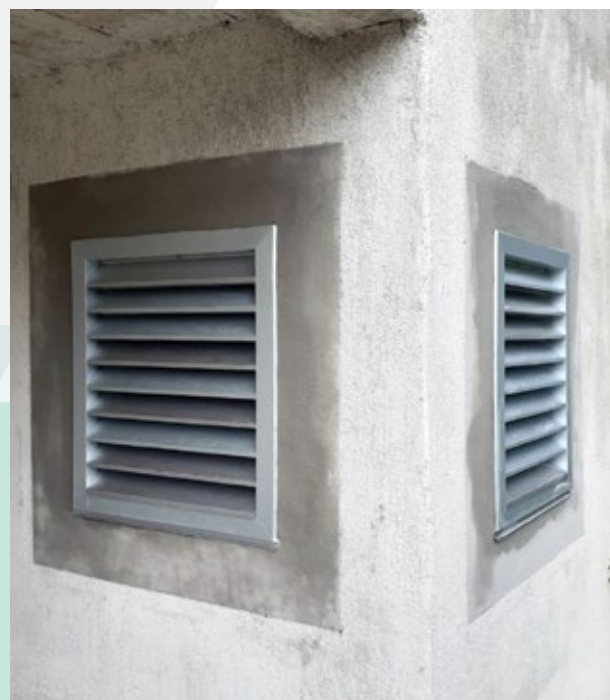
Otvori u zidu za usis i ispuh zraka dizalice topline
