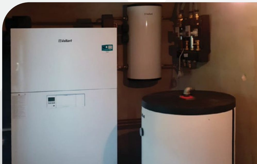
Kotlovnica versoTHERM plus 77/5
