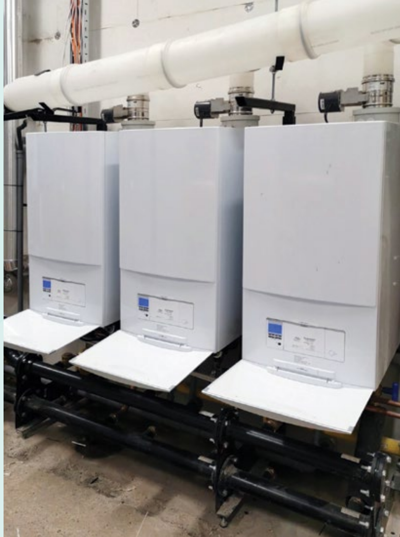
Kaskadni spoj kondenzacijskih uređaja ecoTEC VU 1006/5-5
