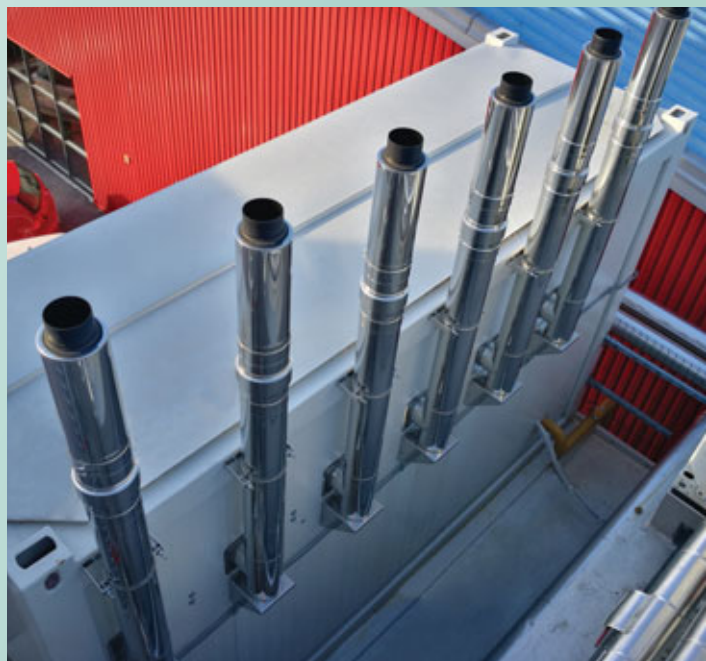
Izvedba dimovoda za dovod zraka/odvod dimnih plinova
