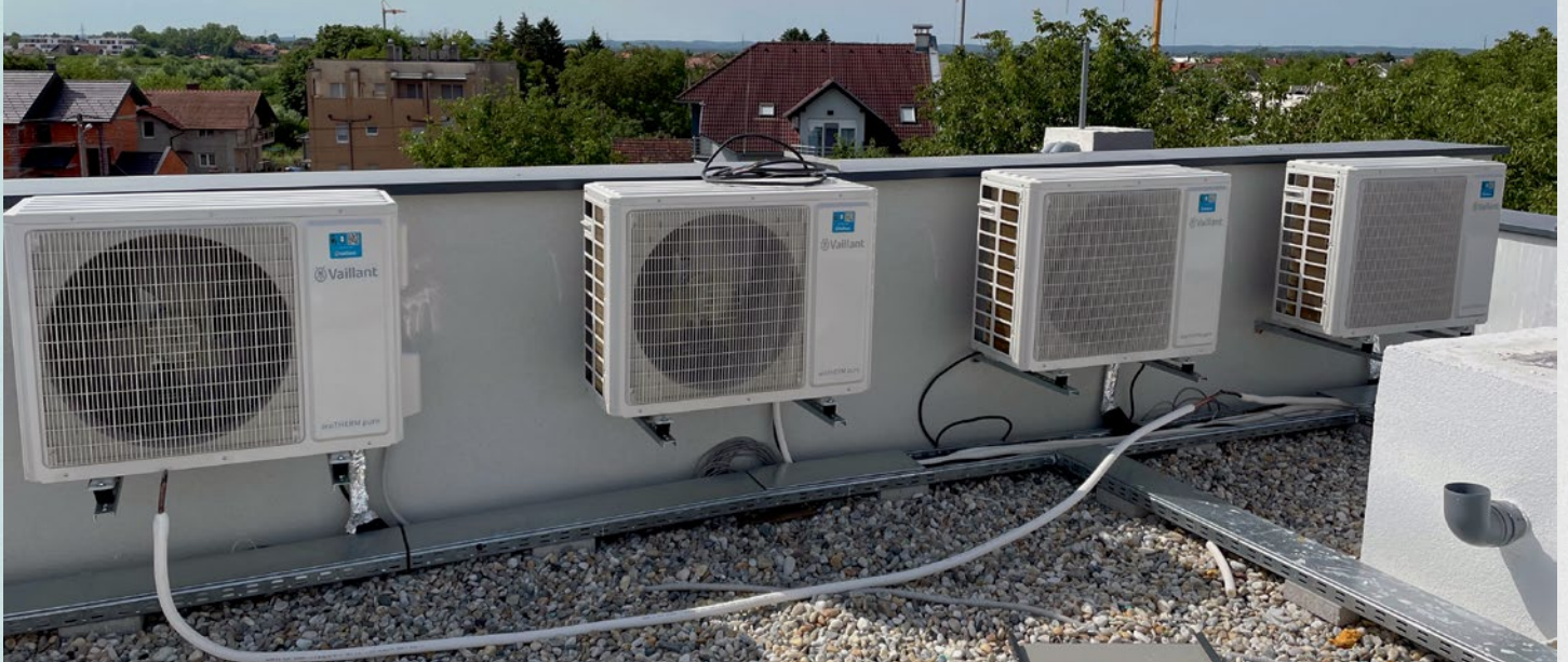
Montirane vanjske jedinice
